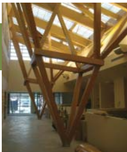
Figure 37 Structure de support en lamellé-collé du pavillon de traitement du cancer
