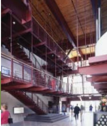
Figure 15 Hall d'entrée et passerelles suspendues en lamellé-collé
