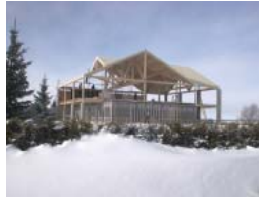
Figure 23 Structure lors de la construction
