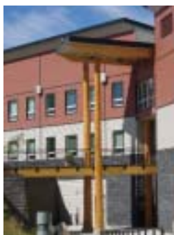
Figure 7 Passerelle de l'entrée principale
