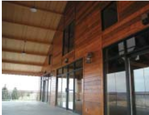
Figure 22 De larges surplombs abritent une terrasse extérieure
