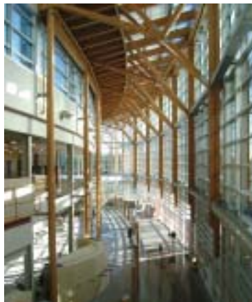
Figure 33 Structure en lamellé-collé du corridor public principal procure une atmosphère clair et optimiste
