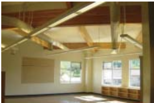
Figure 18 Salle de classe typique (avant ameublement) illustrant la structure du toit et vues de l'extérieur
