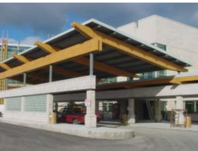
Figure 36 Auvent d'entrée en lamellé-collé
