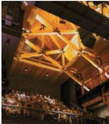
Figure 13 Structure du toit de l'auditorium
