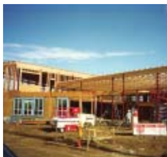
Figure 26 Structure en bois lors de la construction
