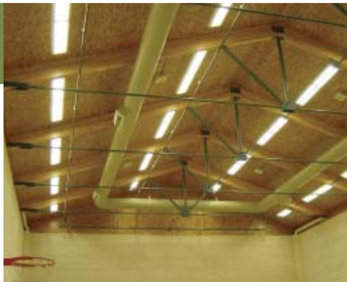
Figure 20 Structure du toit en lamellé-collé avec tirants, système d'éclairage et de ventilation
