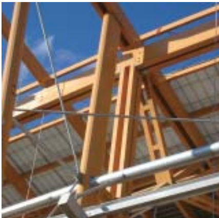
Figure 35 Attaches de gros bois d'oeuvre et tirants
